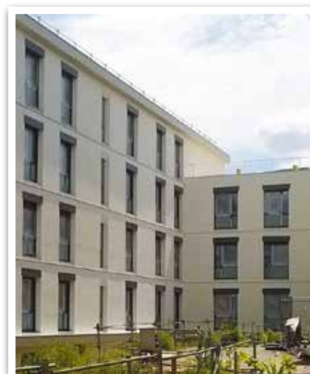
Résidence sociale du Bourget (93) après la première phase de travaux.
